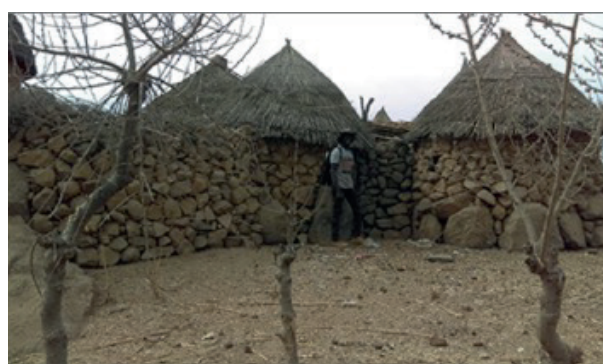
Photo 10 : Fondation faite de pierres sèches de Diy-Gid-Biy ©Hassimi Sambo, mars 2020
