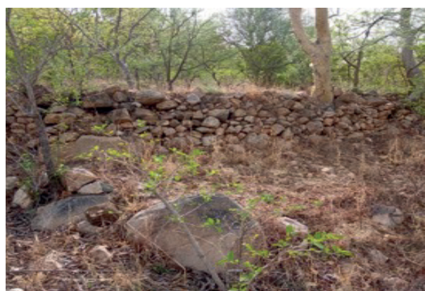
Photo 6 : Structure en muraille de pierres © Hamana, Banaye-Tinguelin, mars 2019
